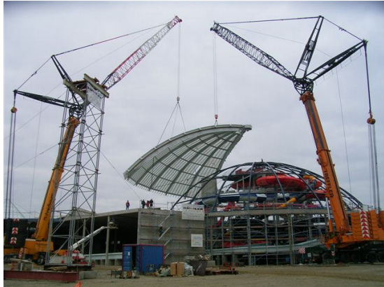
Bild 15: Montagevorgang 90°- Segment (Foto: Architekturbüro Wund)
